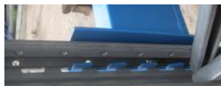
Рис. 1.14. Монтаж каркаса из полузакрытых профилей
