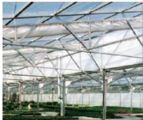
Рис. 1.16. Каркасная теплица из профилей
